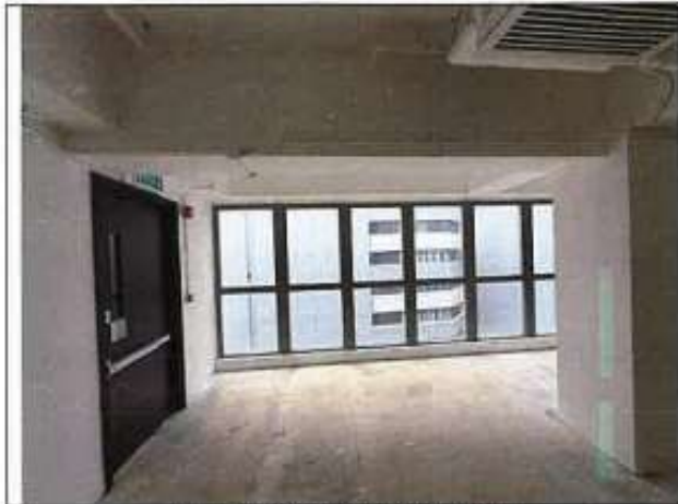
外牆及玻璃窗連鋁質窗框
