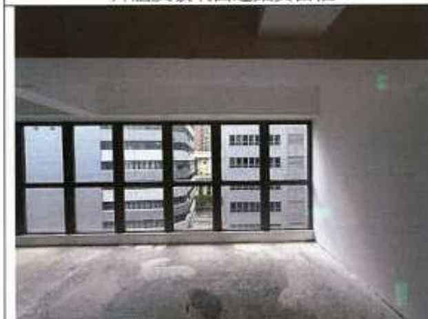
外牆及玻璃窗連鋁質窗框
