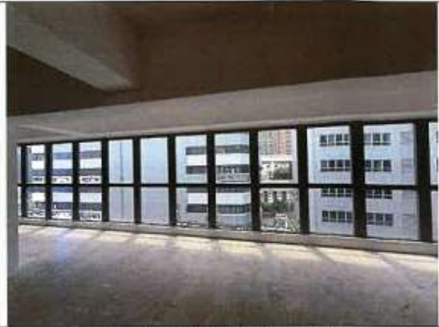
外牆及玻璃窗連鋁質窗框
