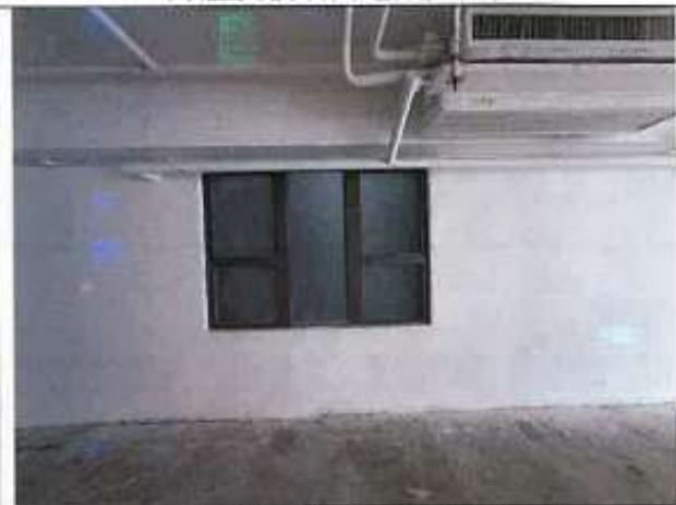
外牆及玻璃窗連鋁質窗框
